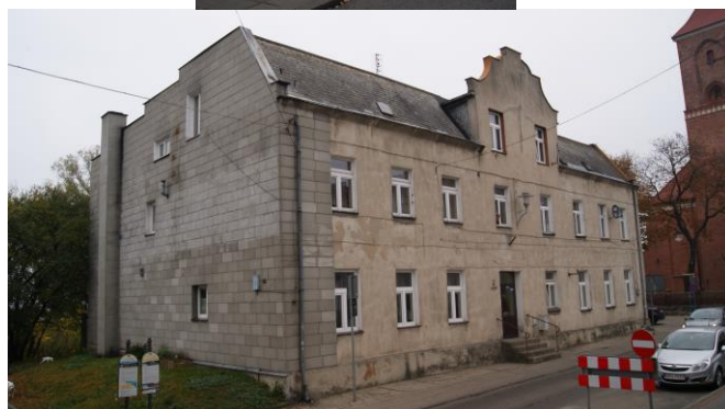
16. Budynek mieszkalny ul. Zamkowa 2 z przełomu XIX i XX w.;
