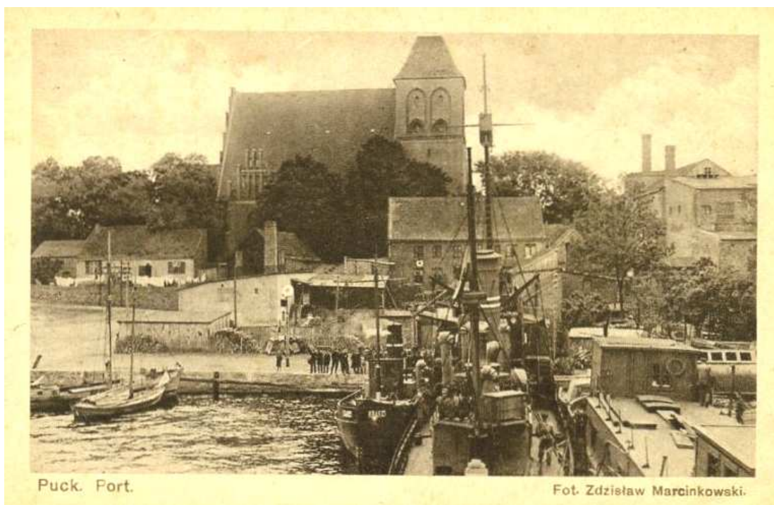
Rys.14. Port w Pucku, początek lat 20.
