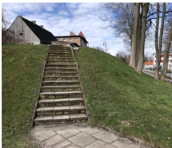
Schody przy ul. Żeglarzy
