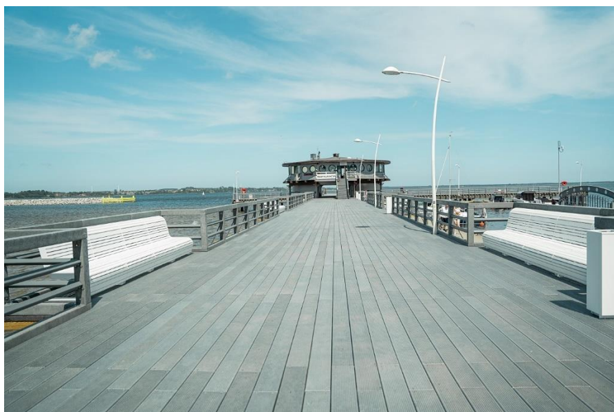
Molo po modernizacji
