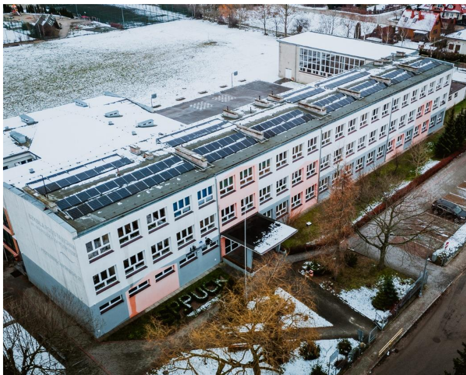
Fotowoltaika na Budynku A Szkoły Podstawowej
